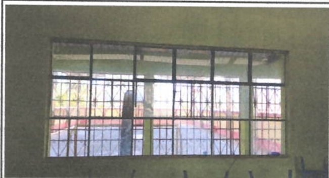
Foto1: SUSTITUCION DE VENTANAS ✓
