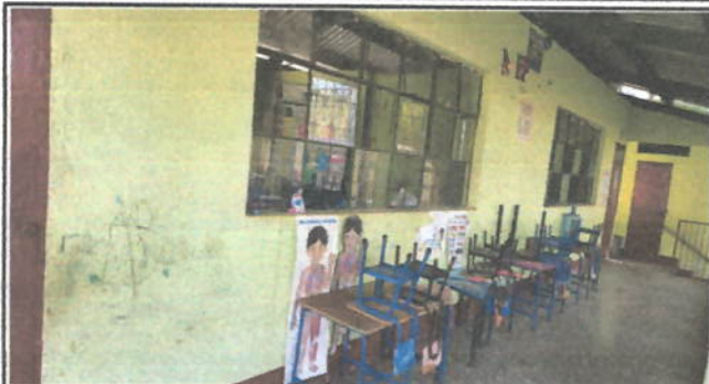
Foto1: PINTURA EN MUROS EXTERIORES E INTERIORES
