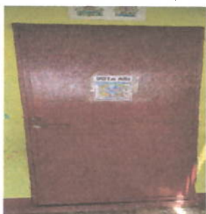
Foto 3: MANTENIMIENTO A PUERTAS
