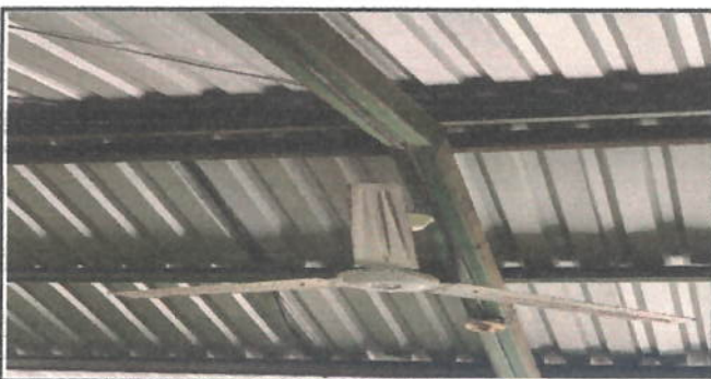
Foto 5: MANTENIMIENTO A ESTRUCTURA
