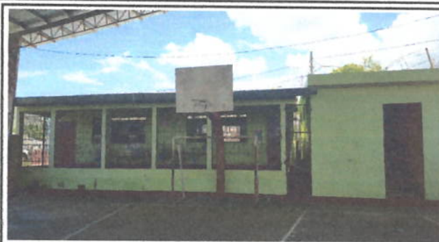
Foto 2: SUSTITUCION DE CANALES ✓
