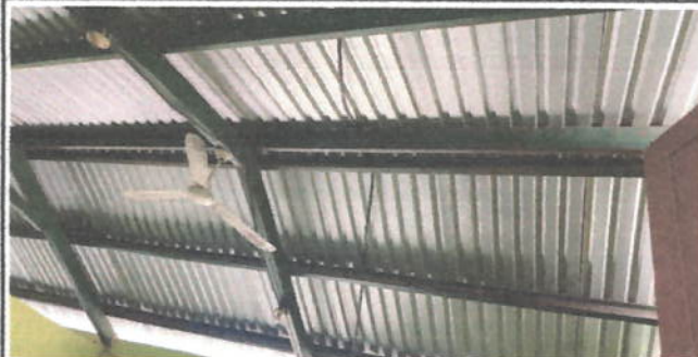
Foto 4: REPARACION DE SISTEMA ELECTRICO
